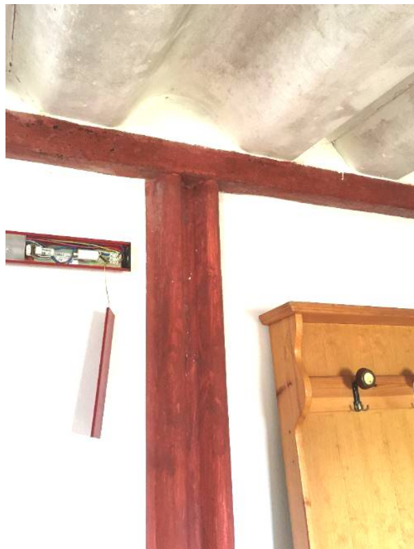
Immagine 2: Pilastrino realizzato mediante lamiera di guard-rail dismessa; La lamiera è verniciata di colore marron.
